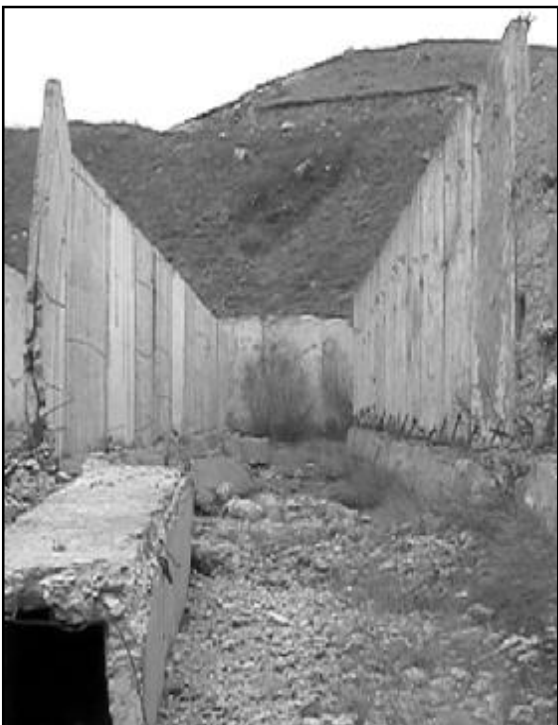
Очистная станция г.Спитак
